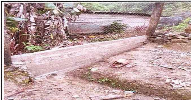
foto 6. el muro esta totalmente terminado
