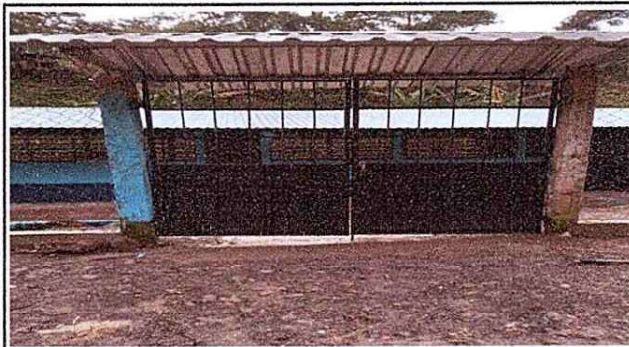
foto 2. el porton totalmente nuevo con el techo nuevo
