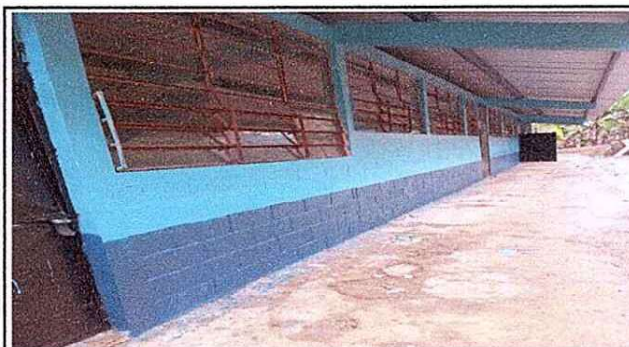
foto 4. los vidrios estan instalados en su totalidad, asi como la pintura de enfrente del establecimiento.
